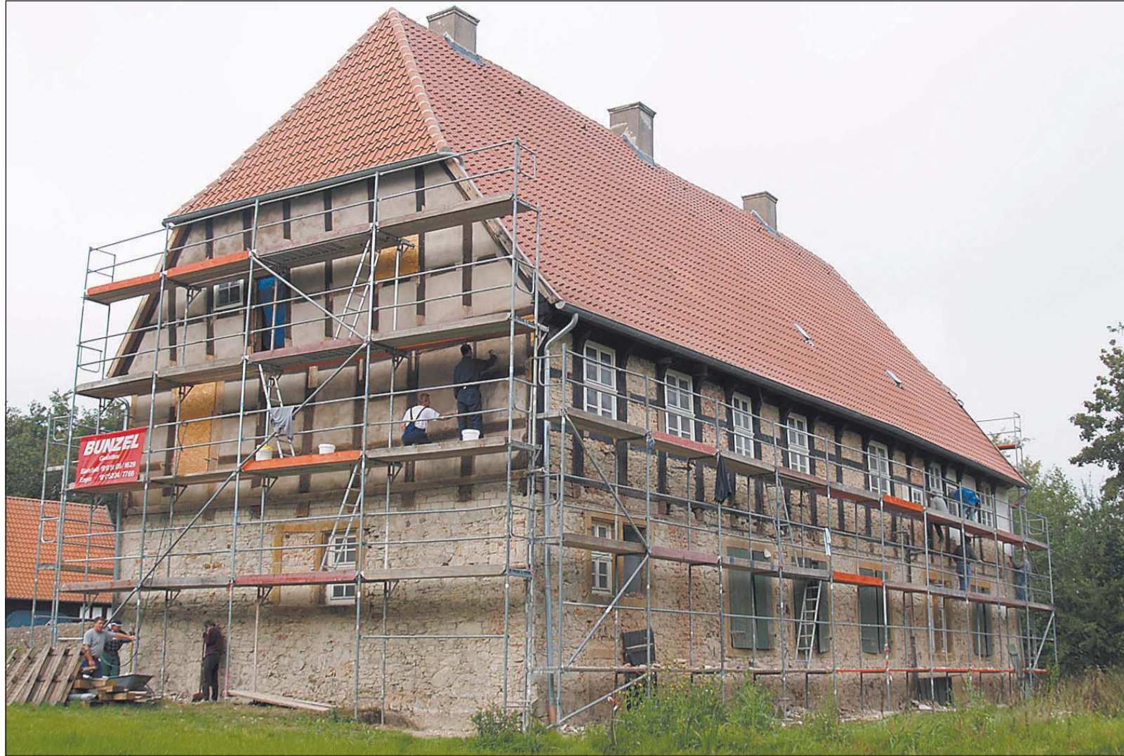
Emsiges Treiben am Spenger Herrenhaus: Das Gebäude datiert aus der Mitte des 15. Jahrhunderts und bildet den Mittelpunkt des Werburger Ensembles. Nun ist es komplett eingerüstet und wird aufwändig und detailgetreu restauriert. Fotos: Daniel Salmon
